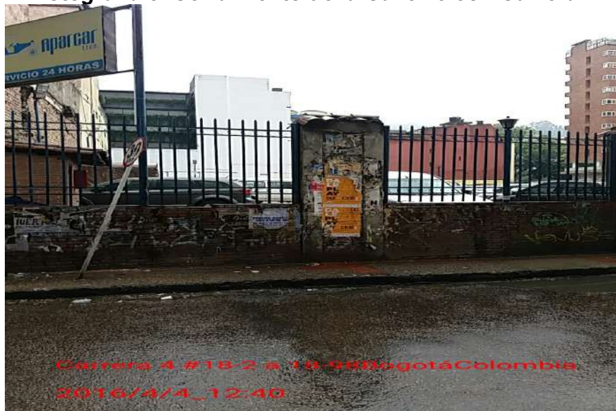
Fotografía 8. Cerramiento de la Calle 19 con Carrera 4
