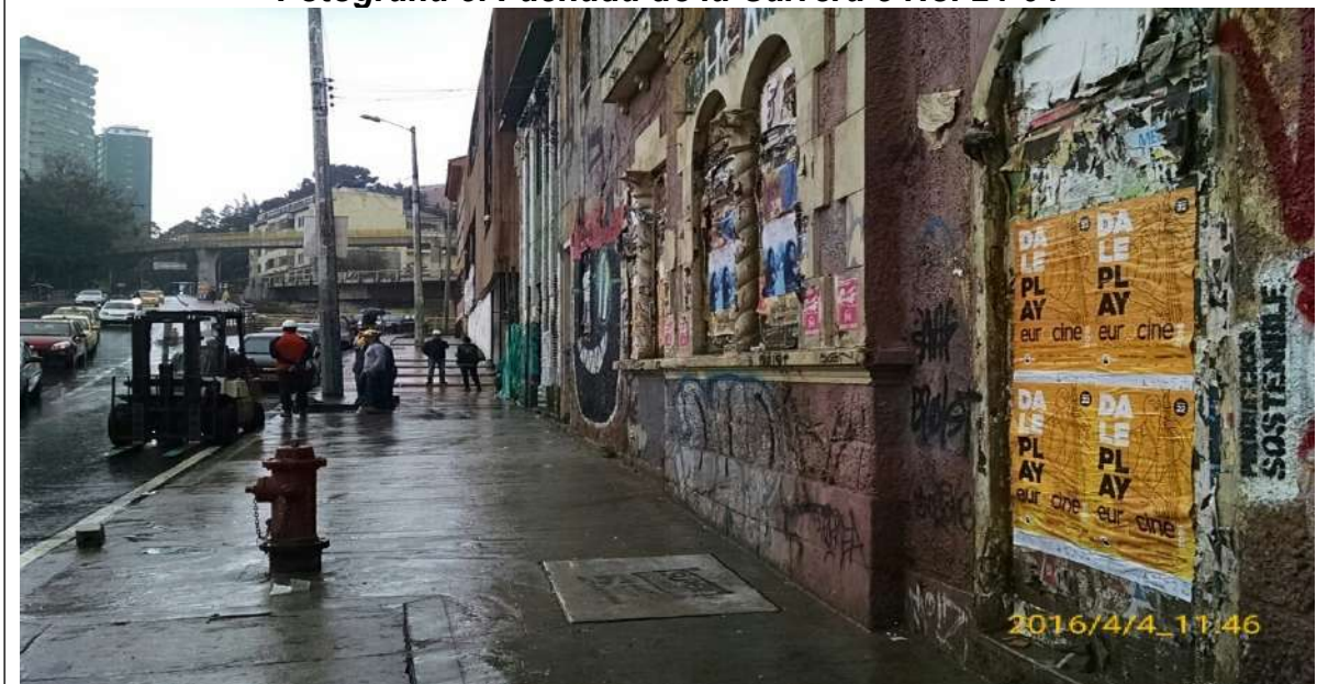
Fotografía 5. Fachada de la Carrera 5 No. 24-04
