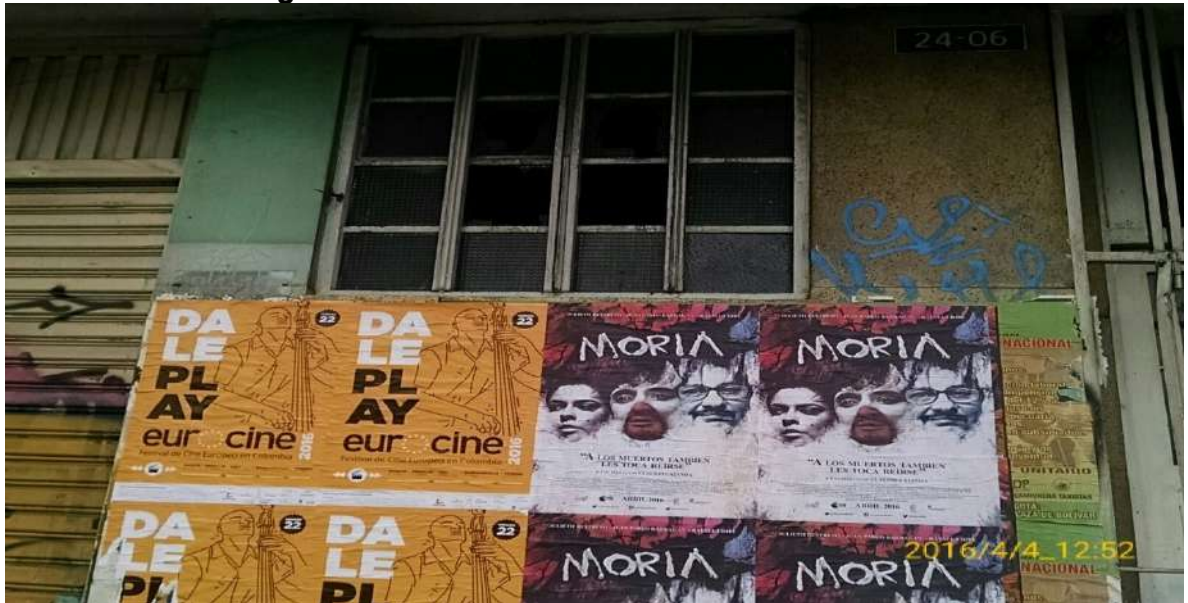
Fotografía 14. Fachada de la Av. Caracas No. 24-06
