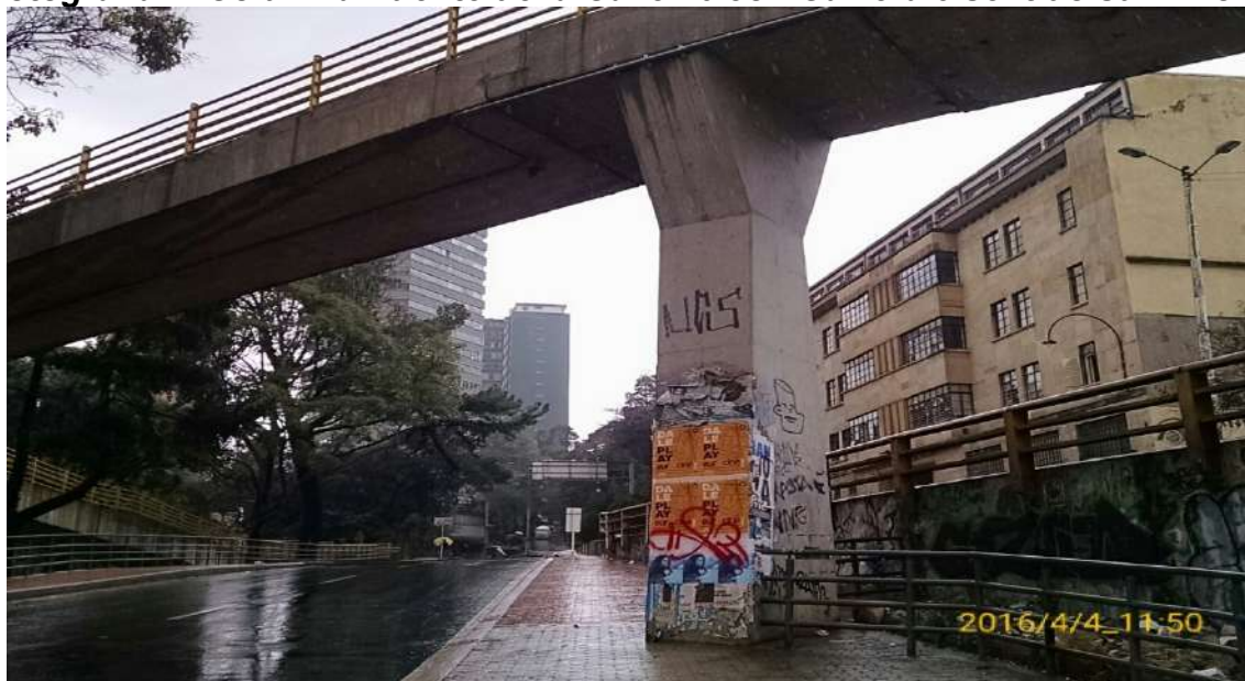
Fotografía 2. Columna Puente de la Calle 26 con Carrera 5 sentido sur – norte
