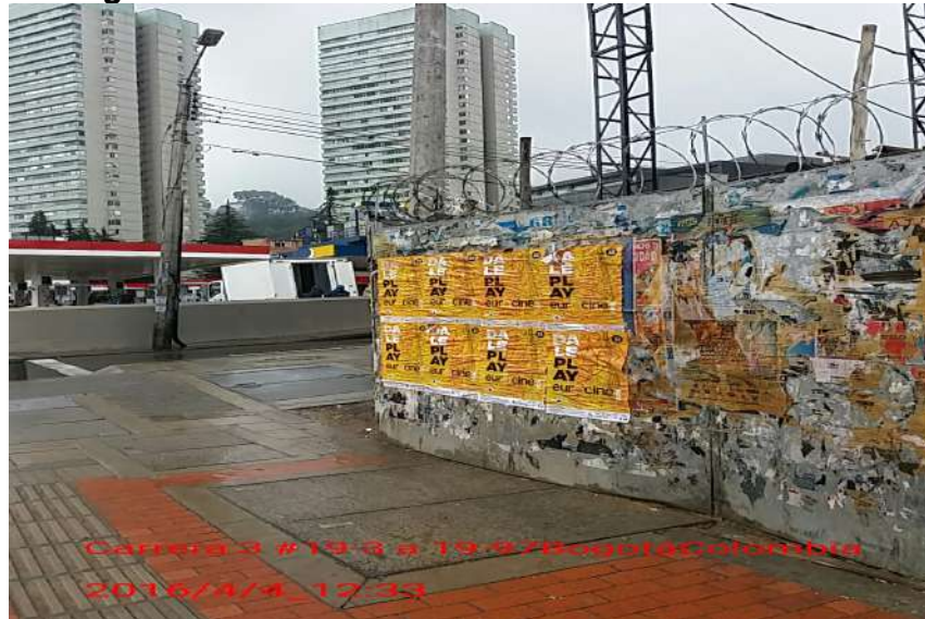
Fotografía 6. Cerramiento de la Calle 20 con Carrera 3
