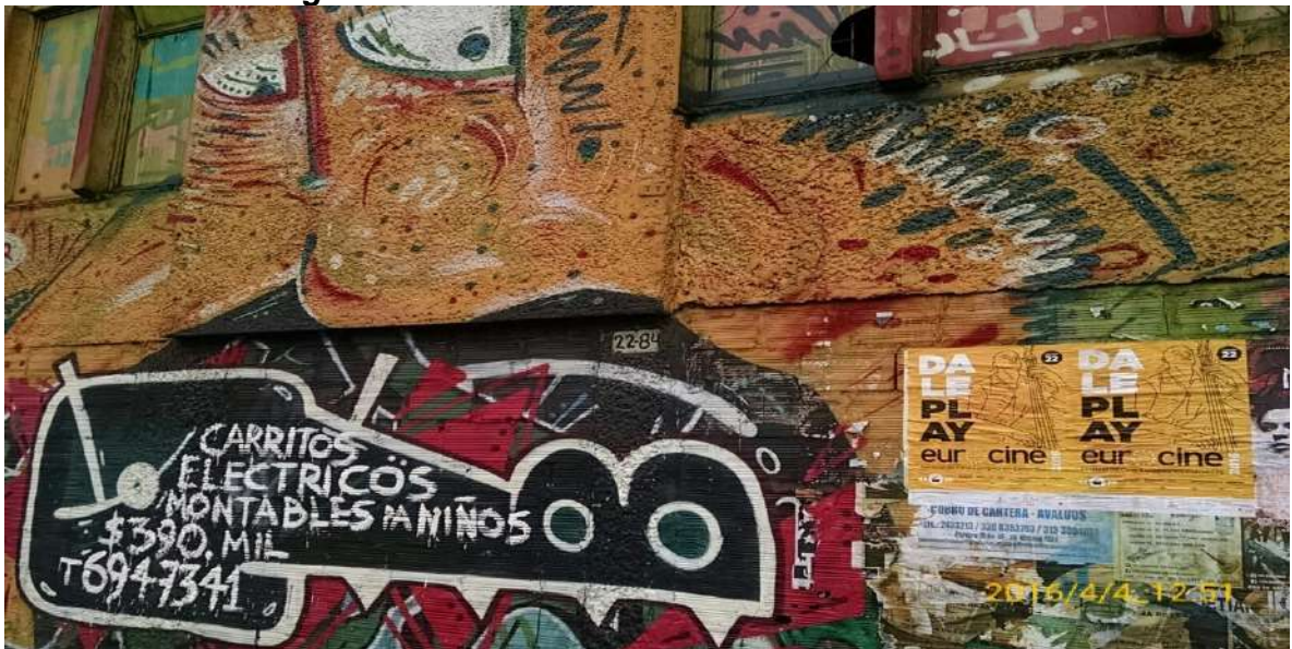
Fotografía 13. Fachada de la Av. Caracas No. 22-84
