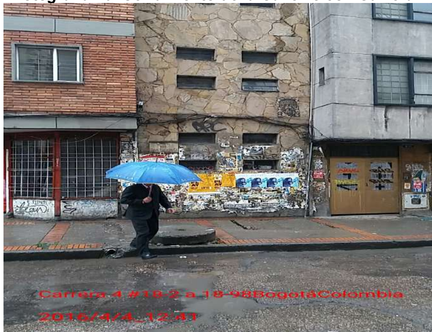
Fotografía 10. Cerramiento de la Calle 18 con Carrera 4
