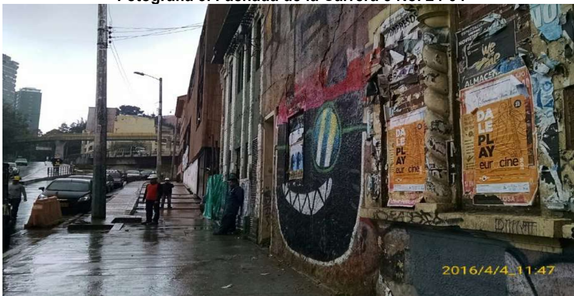
Fotografía 3. Fachada de la Carrera 5 No. 24-04
