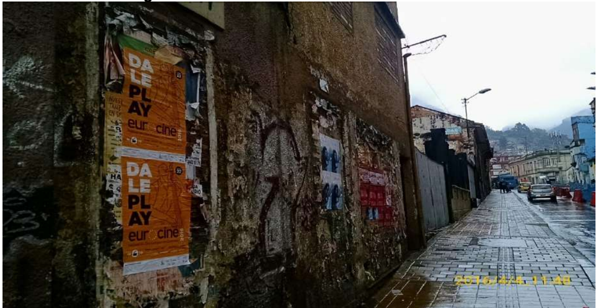
Fotografía 4. Fachada de la Calle 24 con Carrera 5
