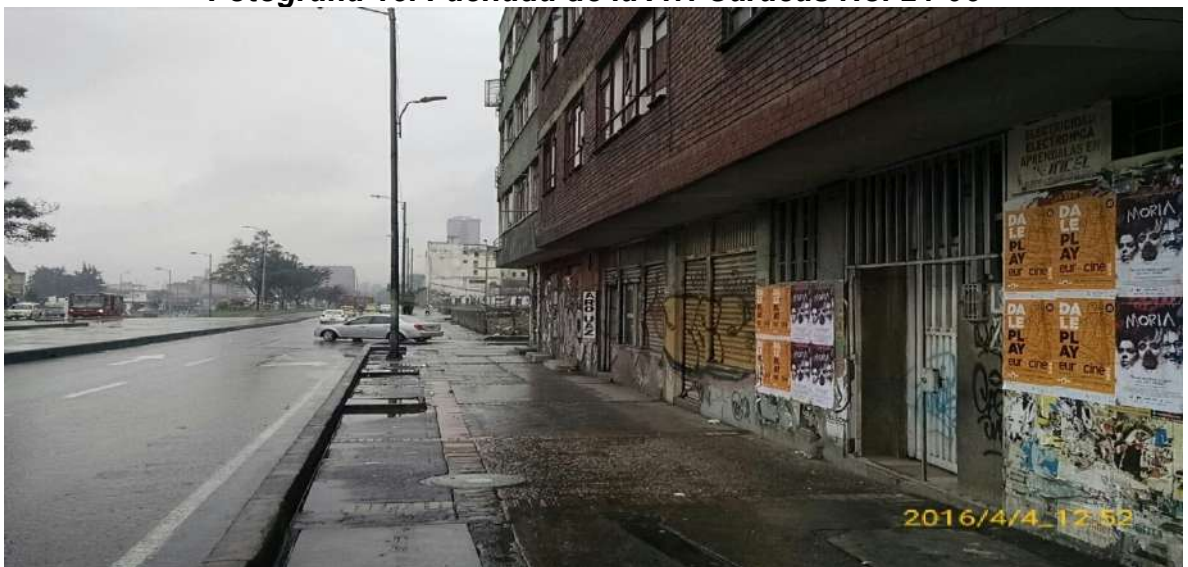
Fotografía 15. Fachada de la Av. Caracas No. 24-06
