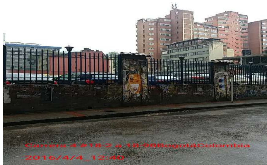
Fotografía 9. Cerramiento de la Calle 19 con Carrera 4
