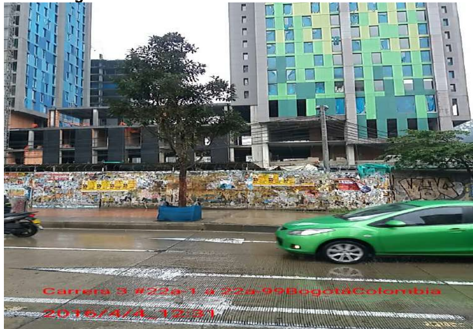
Fotografía 7. Cerramiento de la Calle 19 con Carrera 3
